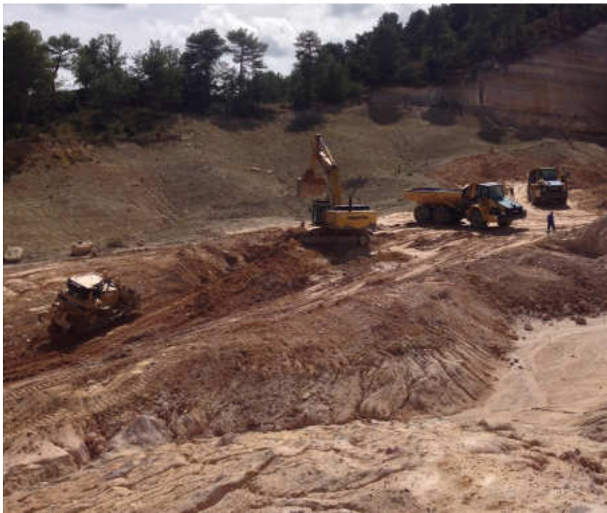
2 MINA MACHORRO EN RESTAURACIÓN
